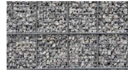
Figur 4.11 Fijnmazigrid in schanskorf toegeven. Schanskorven vullen met zand op graff.
