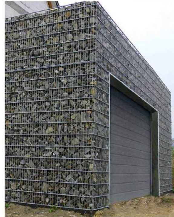
Figur 4.10 Onderstation bekled met schanskorven, deuren en trane in kleur gpo
